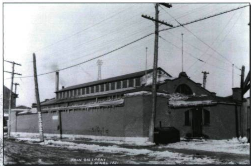
Le bain d'été Gallery, dans le quartier Centre-Ouest, sera démolé en 1932 pour faire place au tunnel Wellington. Photographie mars 1931. (Ville de Montréal. Gestion de documents et archives).
