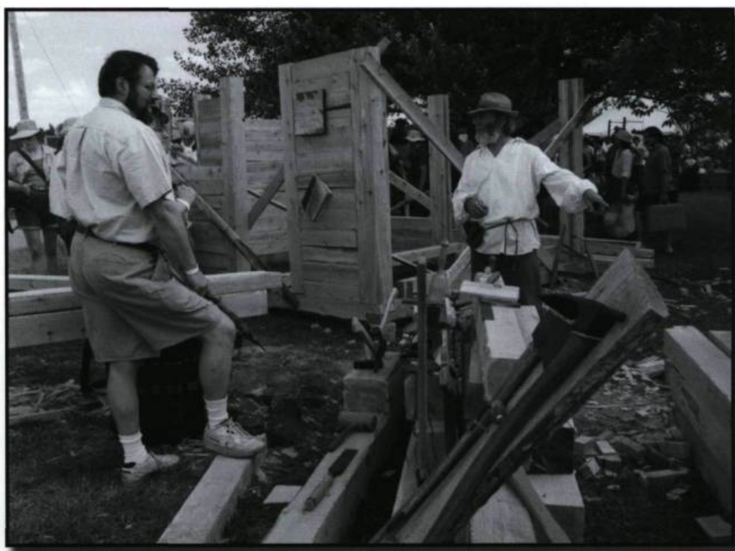
Gaétan Pilon, artisan, construisant une petite maison pièce sur pièce à tenon en coulisse. (Collection Festival des Vieux-Métiers).
