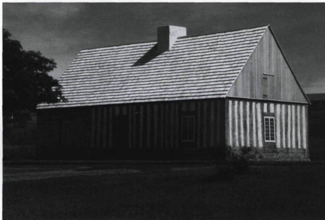
La maison Lamontagne de Rimouski, érigée dans la seconde moitié du XVIII e siècle, demeure l'un des rares vestiges de construction en colombage pierroté. Cette technique, importée de France, sera abandonnée par inadaptation au climat. La maison Lamontagne est un monument historique national. (Archives de l'auteur).
