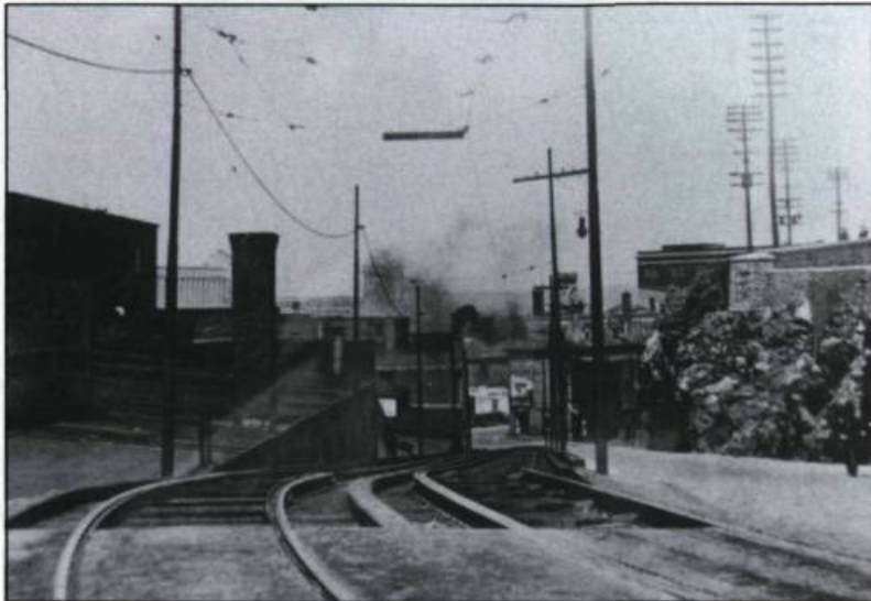
Le viaduc construit au bas de la côte du Palais en direction du carré Parent. De nos jours utilisé par les automobiles, cette voie porte le nom de côte Dinan. (Commission de transport de la communauté urbaine de Québec).
