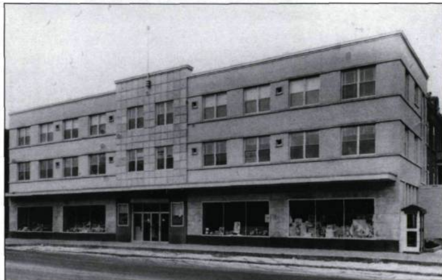
En 1950, le comptable Paul-Henri Simard se porte acquéreur d'un terrain à l'encoignure du boulevard Saint-Cyrille et de l'avenue des Érables. Il fait alors démolir le vieil édifice qui s'y trouve pour y construire le bâtiment actuel. (Archives de la famille Simard)
