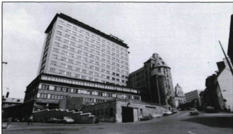
La tour de quatorze étages érigée entre 1959 et 1961 succède au pavillon d'Aiguillon démolli en 1953. (Ville de Québec, Division du Vieux-Québec).
