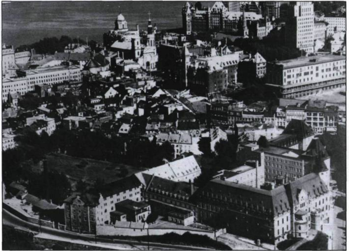
Vue aérienne de l'Hôtel-Dieu vers 1930. (Photographie médicale, Hôtel-Dieu de Québec).
