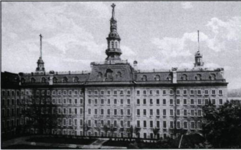
Le pavillon central de l'Université Laval érigé en 1855 par l'architecte Charles Baillaigé. (Carte postale: collection Yves Beaugard).
