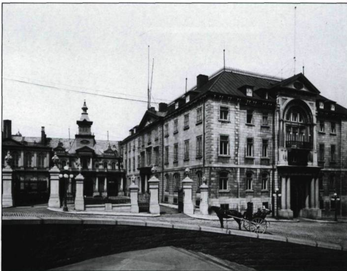
Les «nords» après l'installation du trompe-l'oeil de l'architecte J.-F. Peachy. Fait de bois, l'étagement en relief recrée l'esprit baroque. Il a été conçu pour agrémenter une partie de la cour du cardinal et dissimuler la section du Séminaire abritant les cabinets d'aisance. Photographie de Jules-Ernest Livernois vers 1895. (Fonds Livernois, Archives publiques du Canada).
