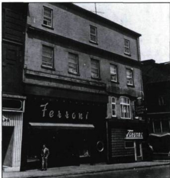
Photographie du bâtiment en mai 1970. (Photo: Service de l'urbanisme de la ville de Québec).
