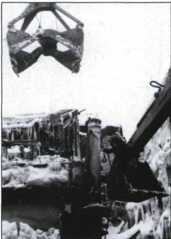
Après l'incendie de ce quadrilatère, un plan de sauvegarde fut mis de l'avant. Lors de la démolition des ruines, certains éléments architecturaux sont conservés puis intégrés à la nouvelle construction. (Photo: Service de l'urbanisme de la ville de Québec).
