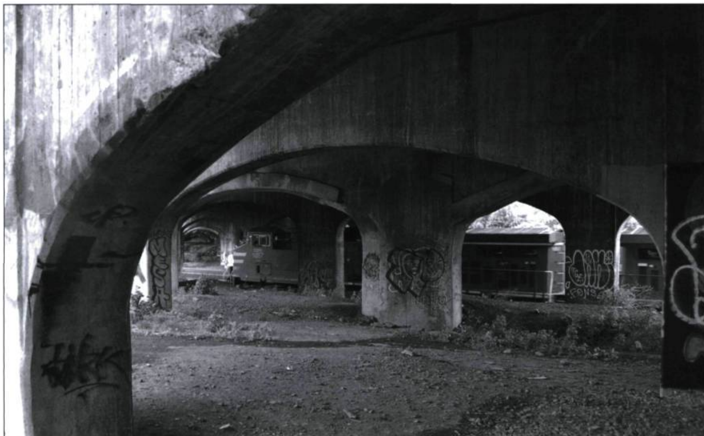
Sous le viaduc Sainte-Catherine au coin de Bercy
