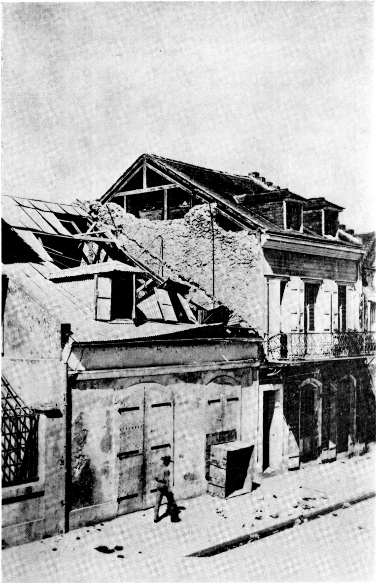
Le tremblement de terre de 1897 à Pointe-à-Pitre Rue d'Arbaud (aujourd'hui rue Achille-René-Boisneuf)
