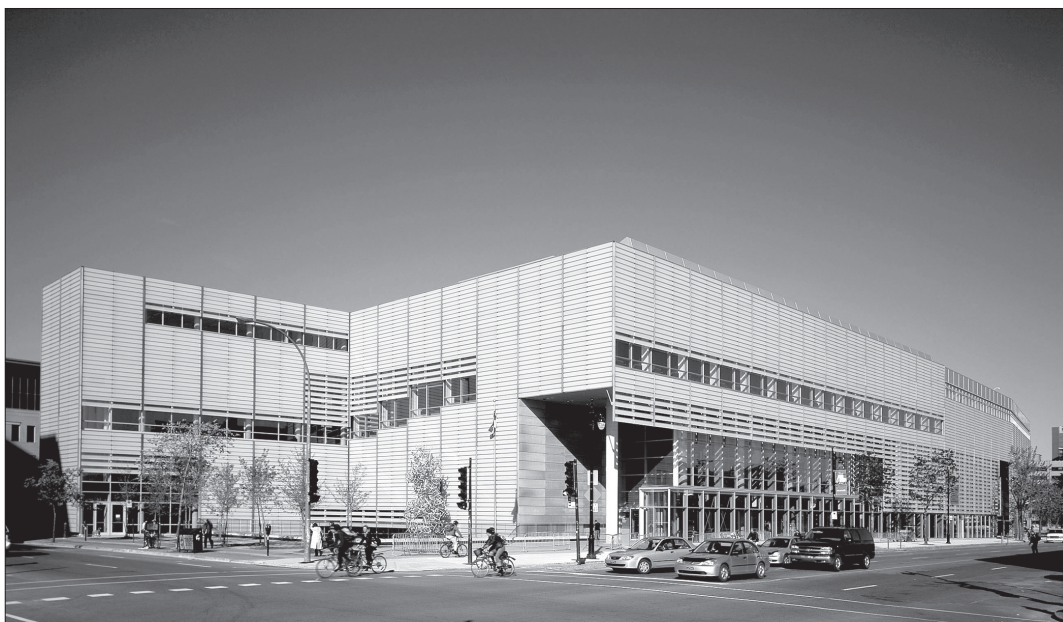
La Grande Bibliothèque vue de l'extérieur
