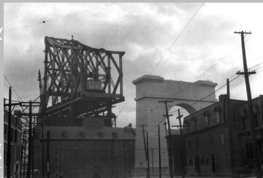
La construction du pont entraîne de nombreuses démolitions dans le quartier Sainte-Marie. (Compagnie Dominion Bridge, Bibliothèque et Archives Canada)
