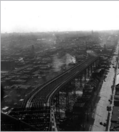
L'approche nord s'enfonce profondément dans le quartier Sainte-Marie.
