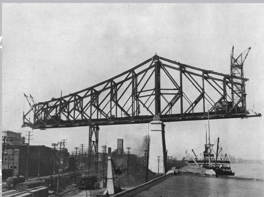
Construction en cantilever, pilier n° 25 dans le port, en 1928. (Source : Compagnie Dominion Bridge, Bibliothèque et Archives Canada)
