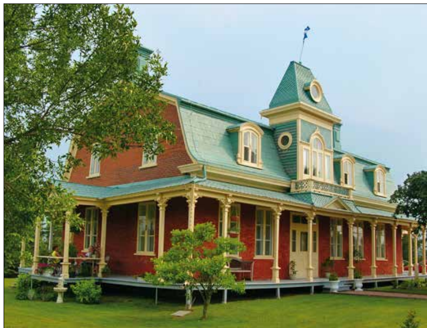
Les propriétaires de bâtiments possédant un caractère architectural particulier, comme ce presbytère de style Second Empire de Saint-Zéphirin-de-Courval, souhaitent généralement que, advenant un sinistre, leur demeure soit reconstruite dans les règles de l'art.
