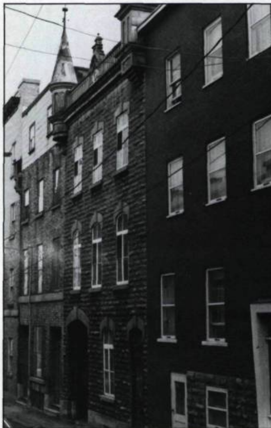
Plusieurs édifices du faubourg ont reçu un décor de «style château» vers 1890-1900. Les architectes Elzéar Charest, Georges-Émile Busières vont l'implanter dans le faubourg. (Photo: Service des ressources pédagogiques, Université Laval).
