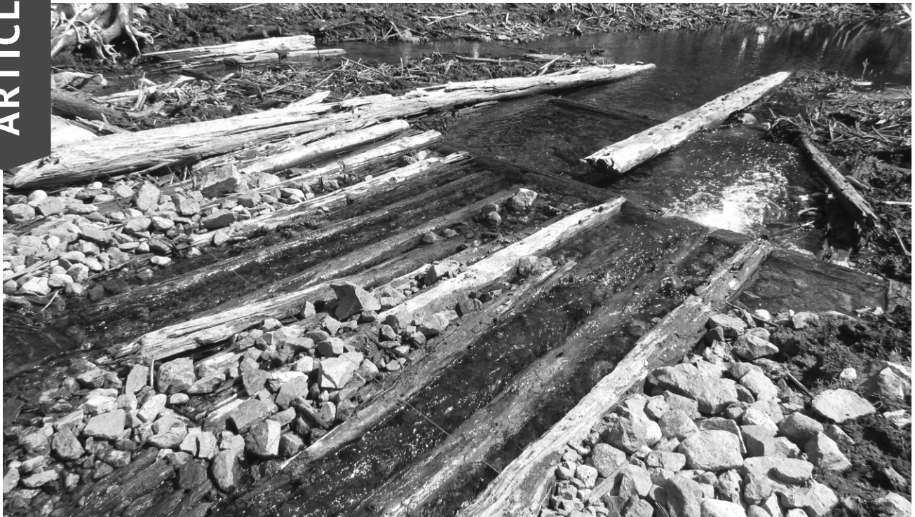
Vestiges du barrage de drave de 1870 au lac Houle. (Source : Parcs Canada).
