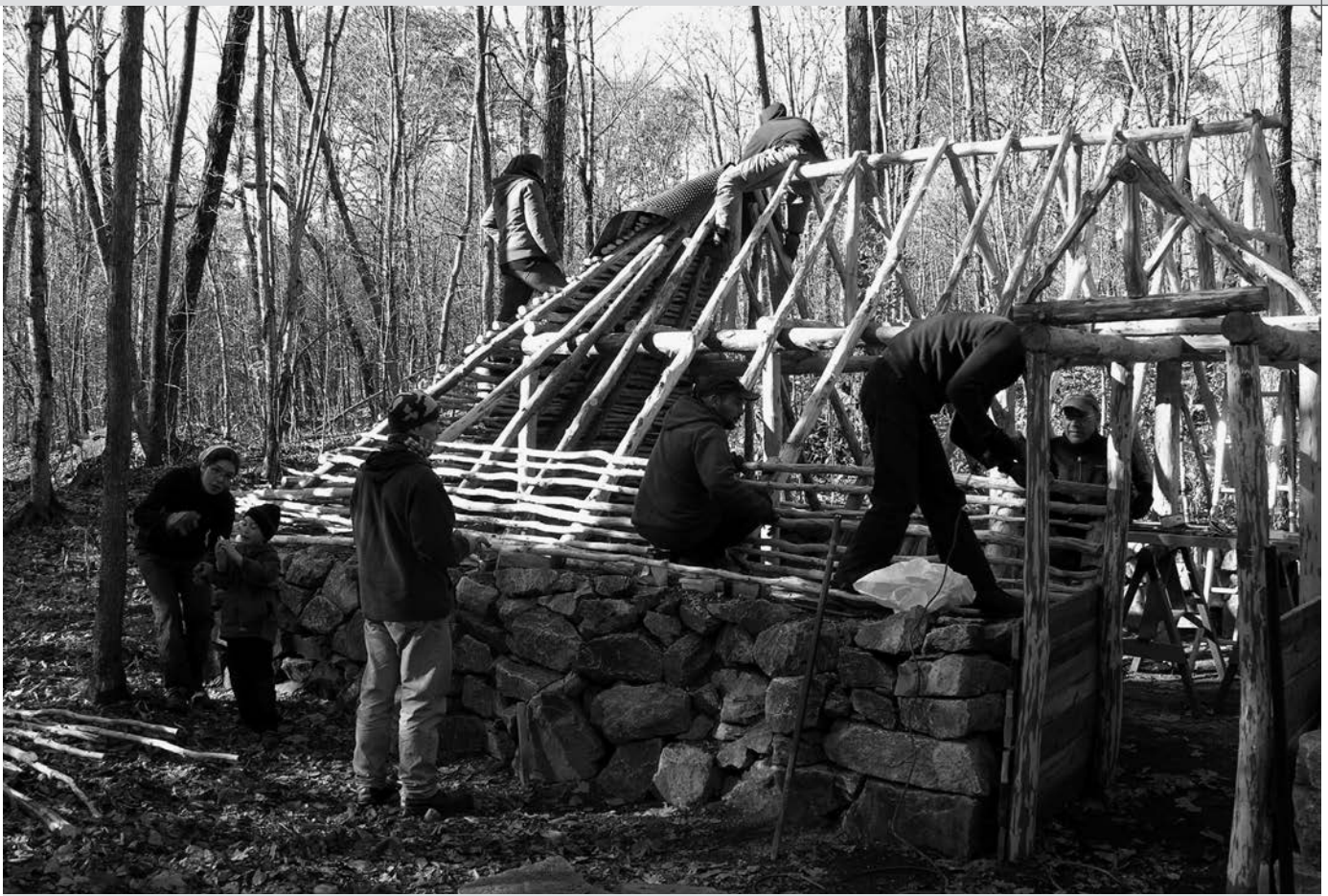
Une armée de fourmis construisant une maison viking (25 octobre 2009). (Archives de l'auteur).
